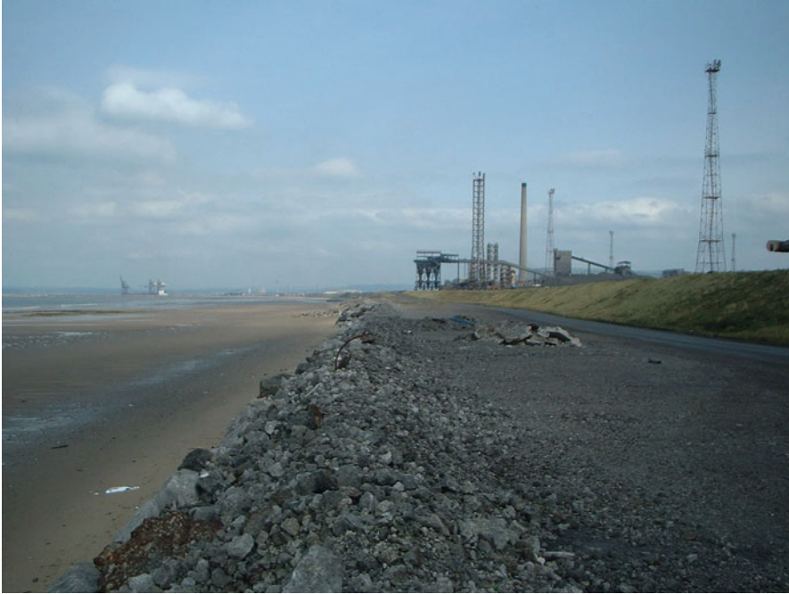
Fig. 17.8 Blast furnace slag revetment
