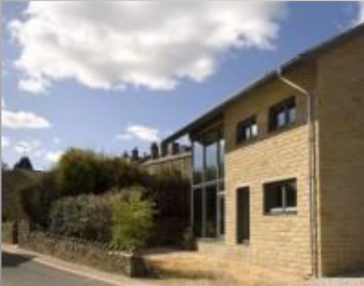
Denby Dale Passivhaus
