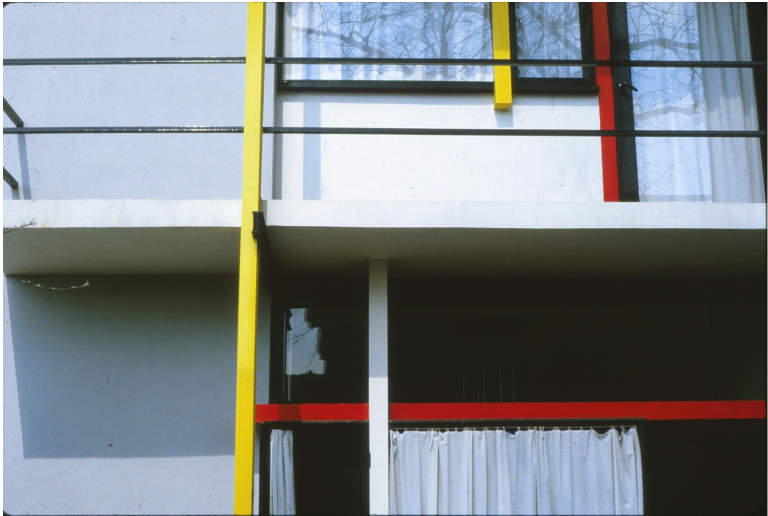
Schroder House – Utrecht – 1924 – Gerrit Rietveld
