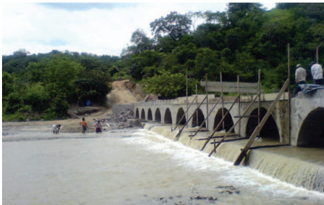
Vehicle bridge: Las Cruces – San Fernando
