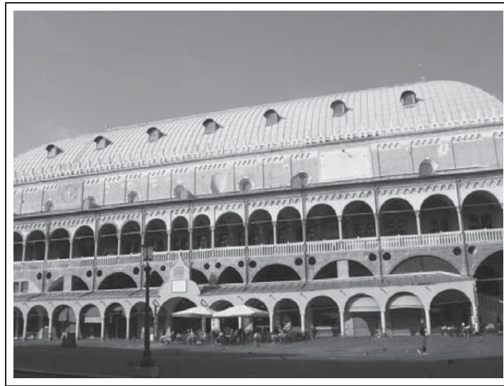
Figure 1. Exterior Palazzo della Ragione, south face. Photo: D. Gunzburg.
