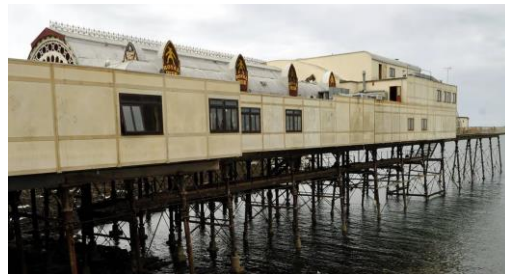
Ar y pier
