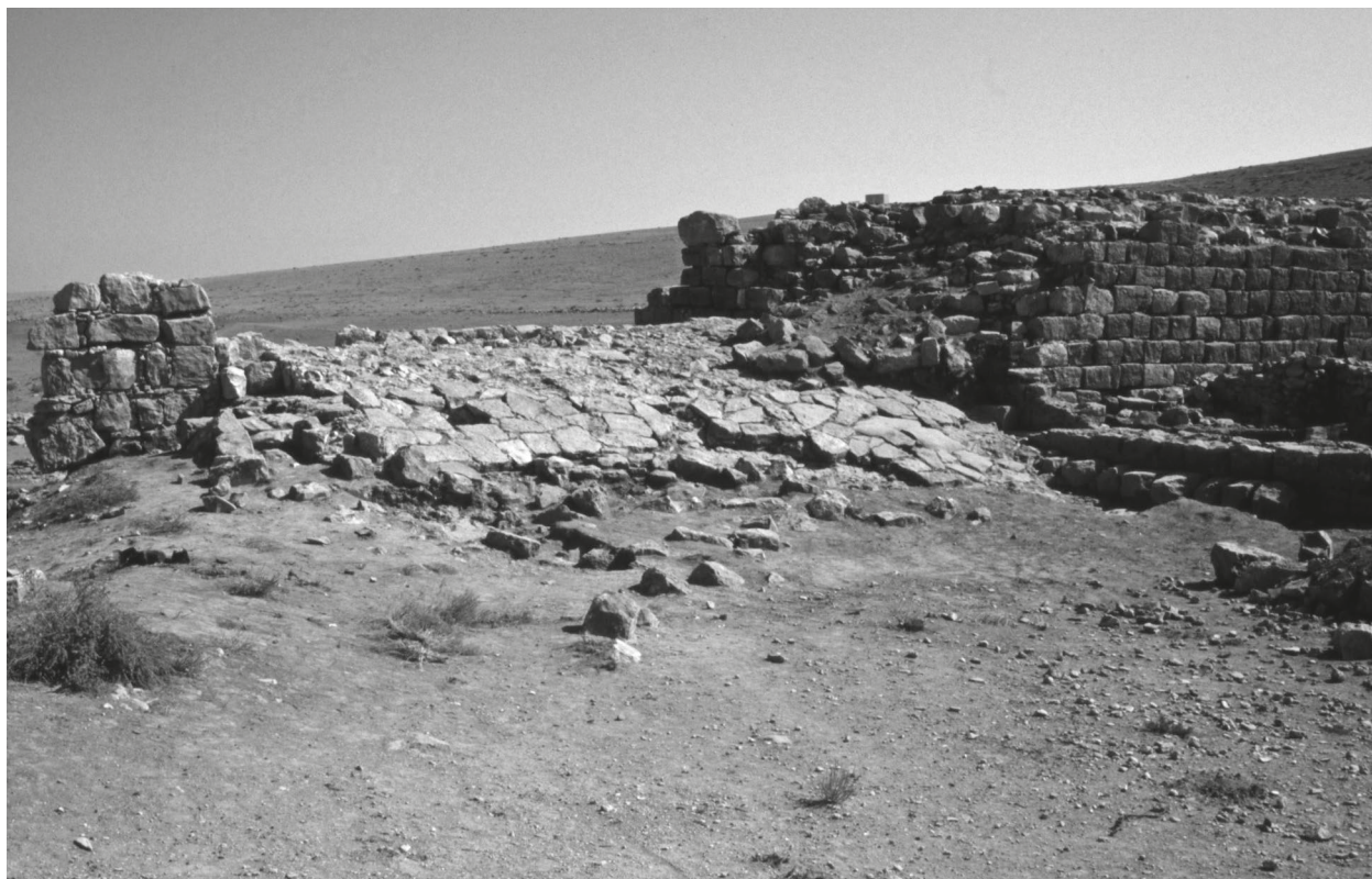
Figure 13 – Umm al-Walīd / Wādī al-Qanāṭir, déversoir du barrage amont. [Cliché : D. Genequand]
