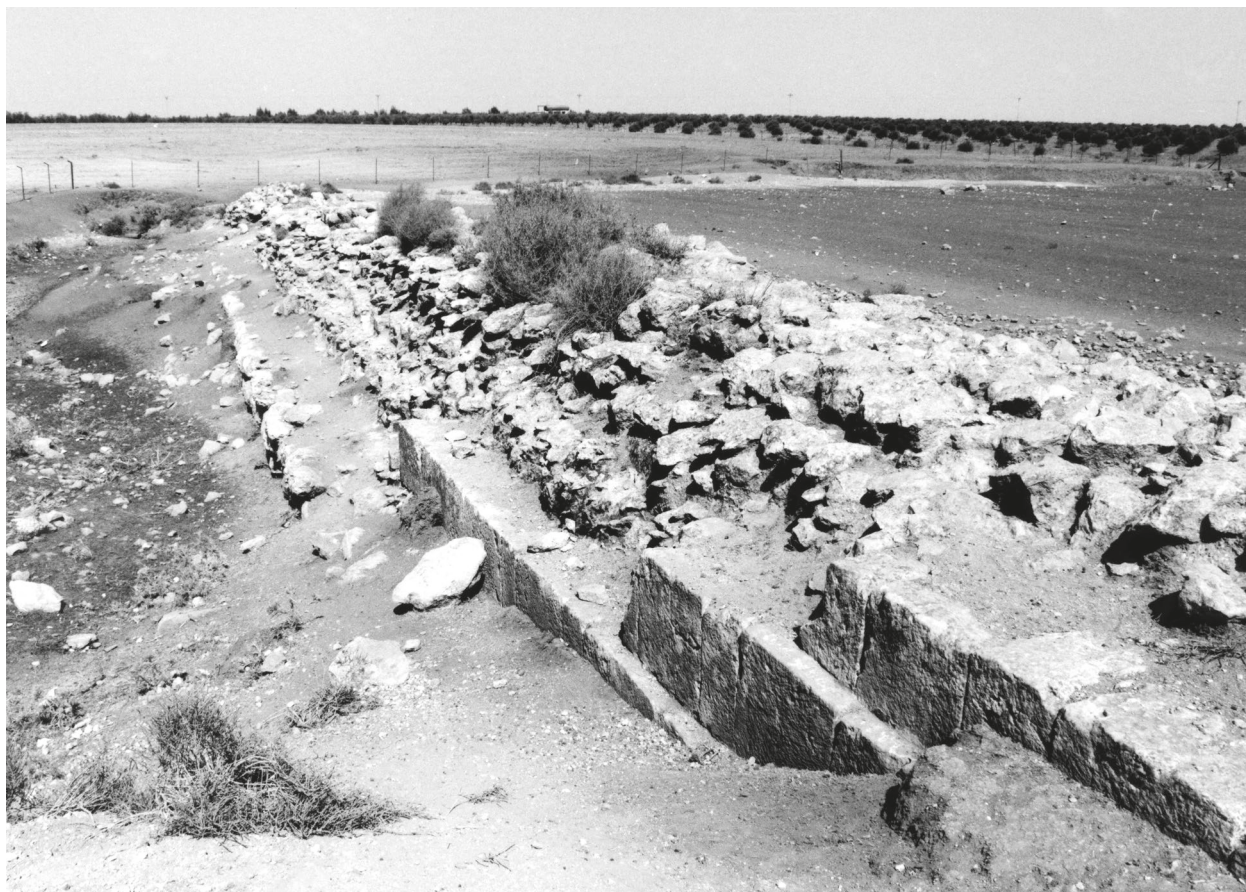
Figure 20 – Al-Qasṭal, vue de l'extrémité nord-est du barrage aval. [Cliché : D. Genequand]
