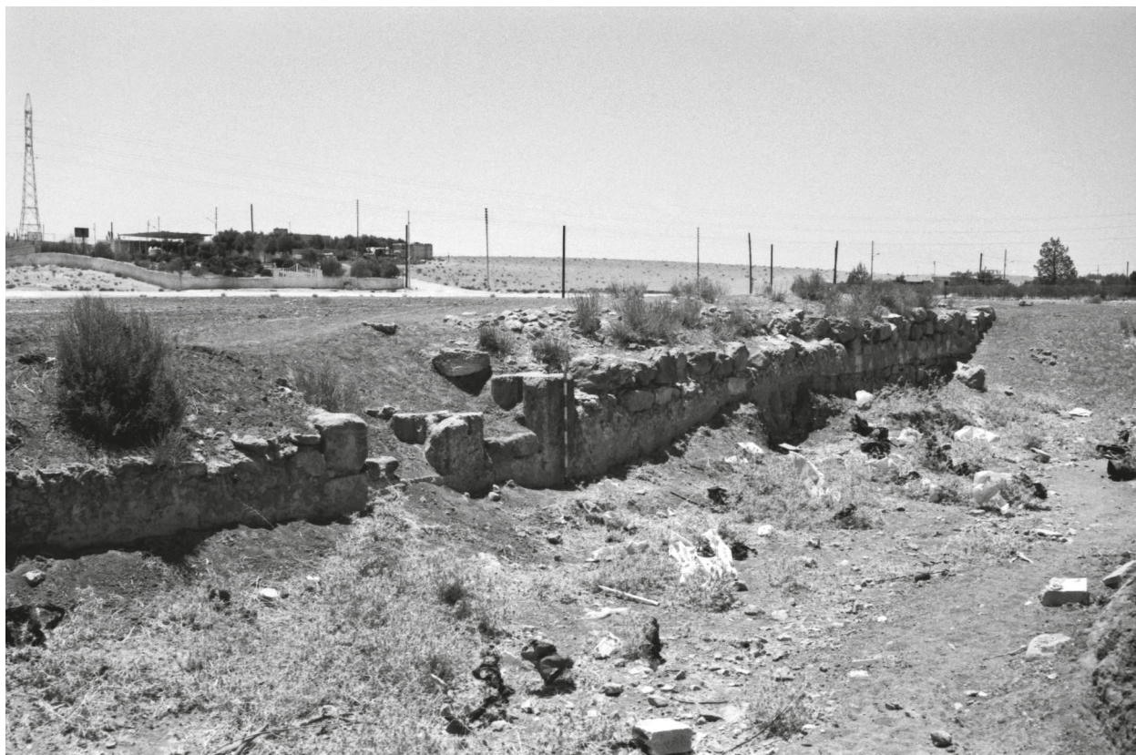
Figure 19 – Al-Qasṭal, vue du barrage amont ; au centre, à gauche du jalon, les deux exutoires. [Cliché : D. Genequand]
