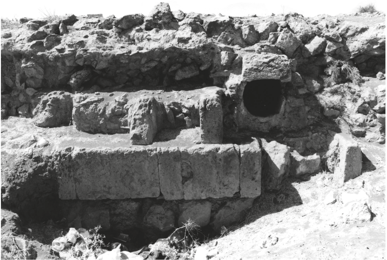
Figure 22 – Al-Qaşṭal, vue du débouché de l'un des exutoires du barrage aval. [Cliché : D. Genequand]
