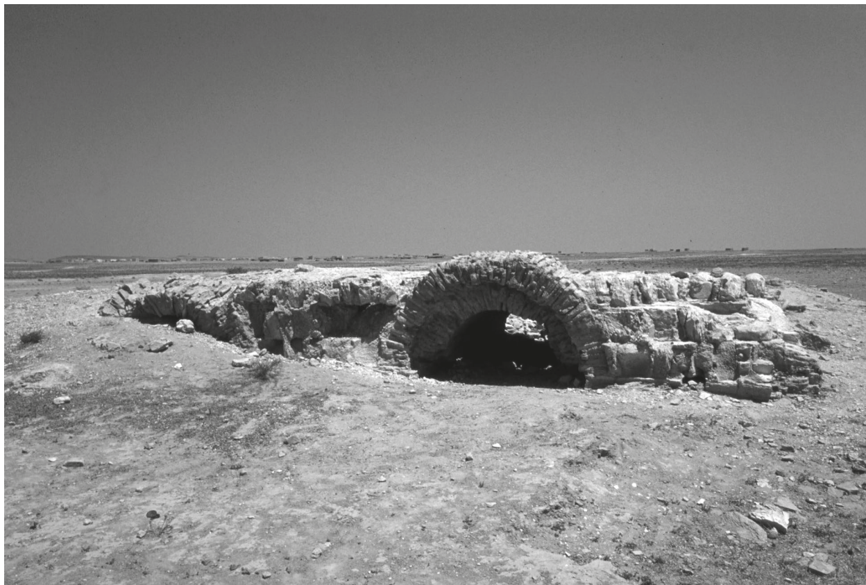
Figure 4 – Qaṣr al-Ḥayr al-Sharqī, vue des vestiges de l'un des exutoires du barrage. [Cliché : D. Genequand]
