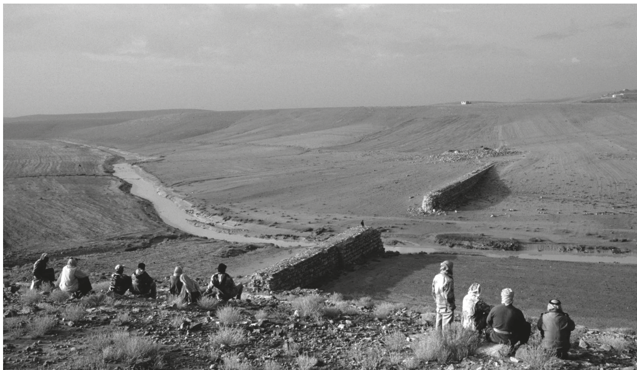
Figure 14 – Umm al-Walīd / Wādī al-Qanāṭir, vue du barrage aval. [Cliché : J. Bujard]
