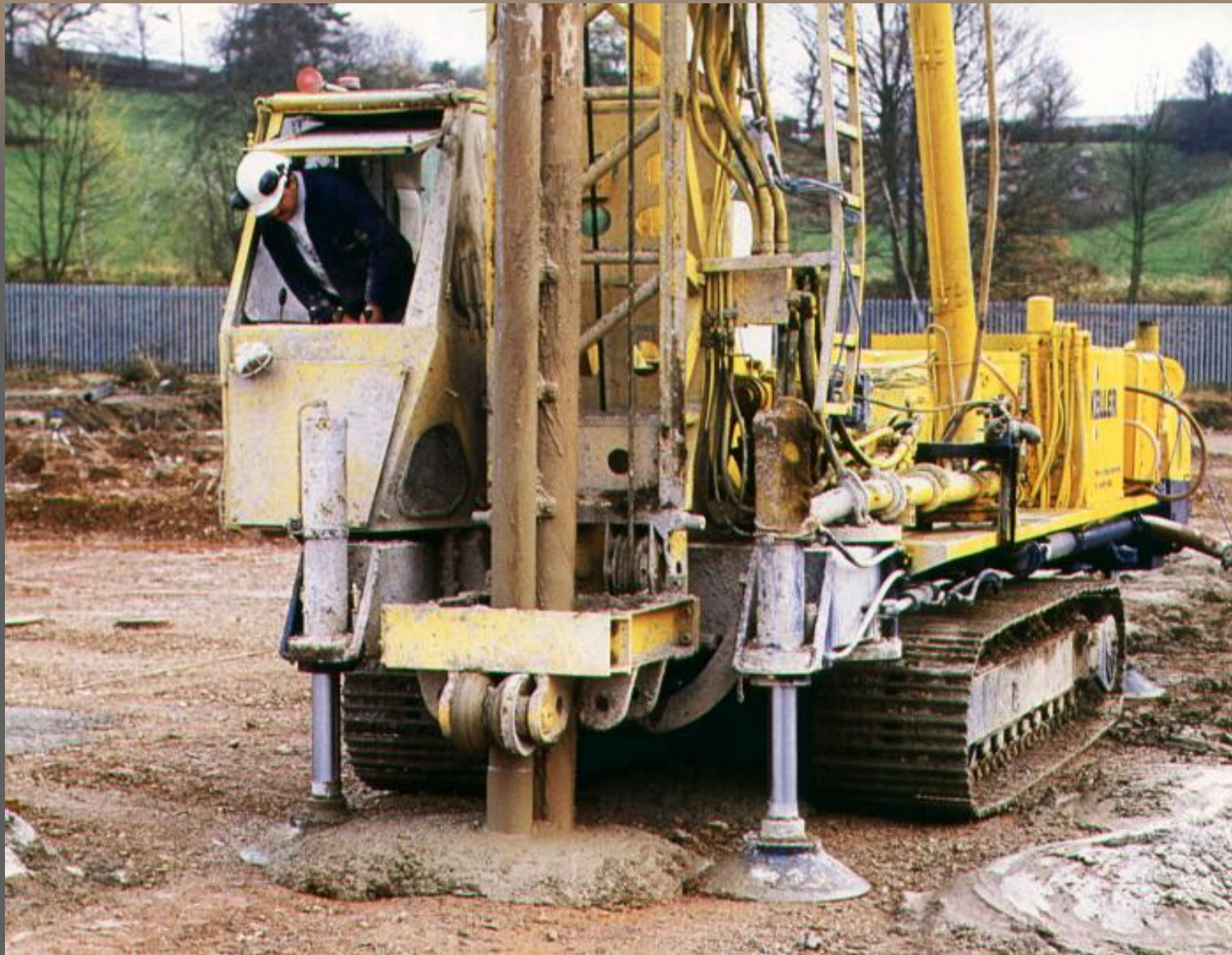
Vibro concrete columns
