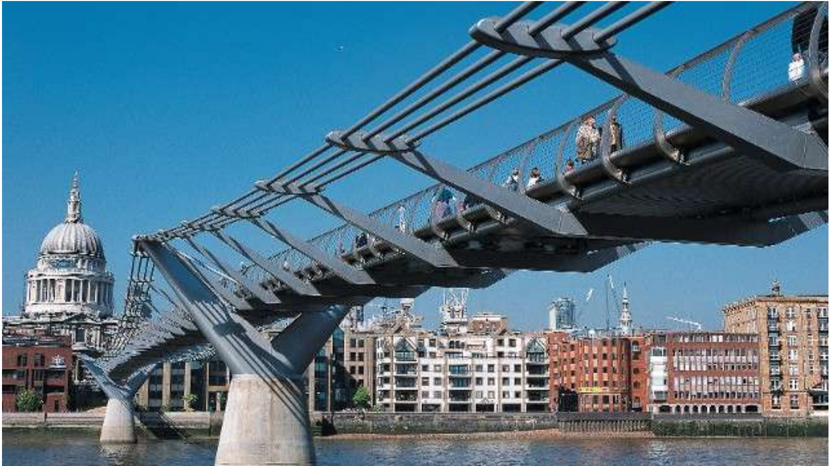
Millenium bridge. London.
