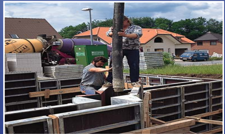
Poured In-Situ Basement Wall
